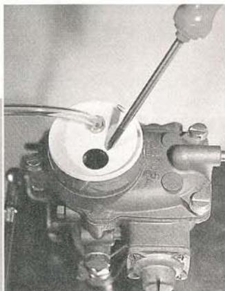
Die (luftdichte) Schlauchdurchführung wird verstärkt
